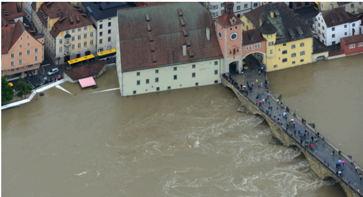
Abb. 4-2: Regensburg, Einsatz der Notfallsysteme
