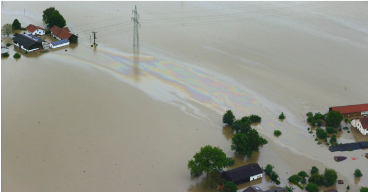
Abb. 7-1: Durch das Hochwasser verursachter Ölschaden
