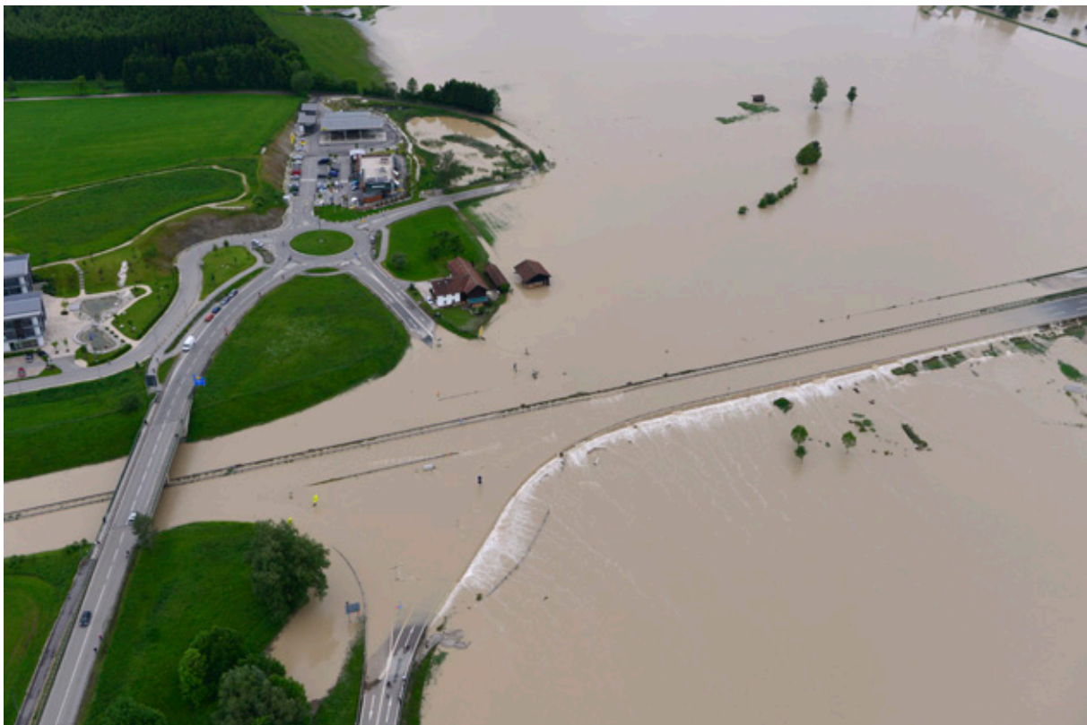
Abb. 4-9: Überflutung der Bundesautobahn A8, Anschlussstelle Grabenstätt
